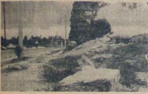
Calle López Escribano. La arteria fue reacondicionada pero los escombros quedaron. Siempre falta 5 para el peso.
